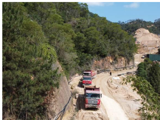
项目航拍照片
