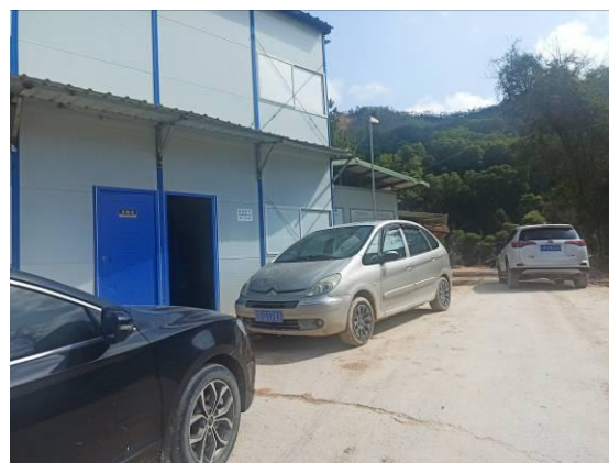
综合服务区现状
