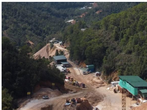
项目航拍照片
