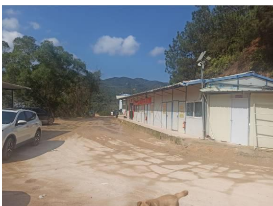
综合服务区现状
