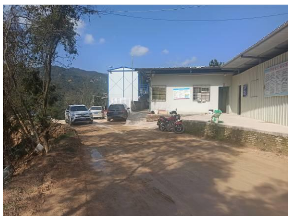
综合服务区现状
