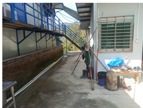
综合服务区现状
