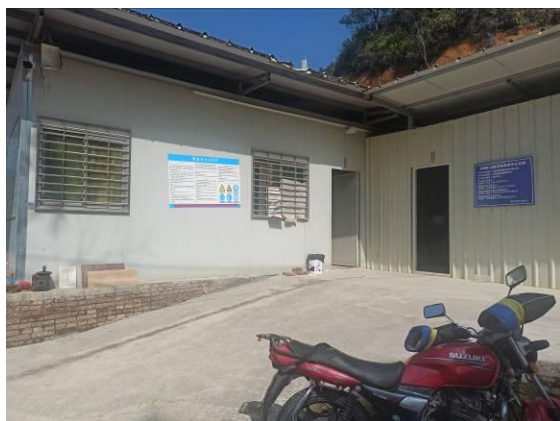
综合服务区现状
