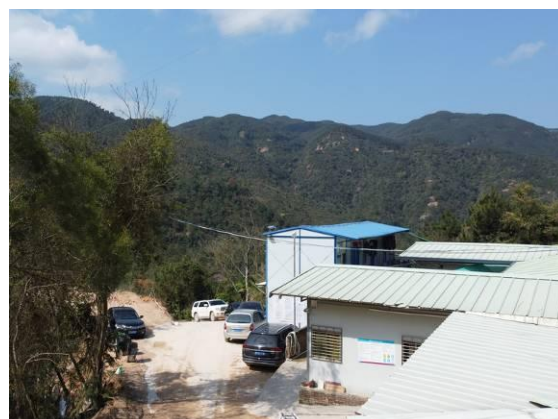
项目航拍照片
