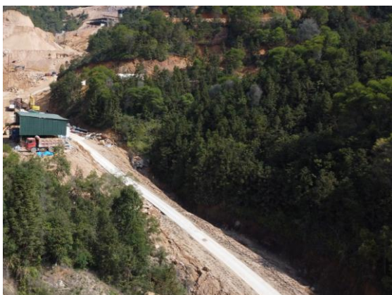
项目航拍照片
