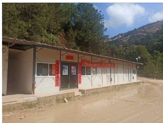
综合服务区现状
