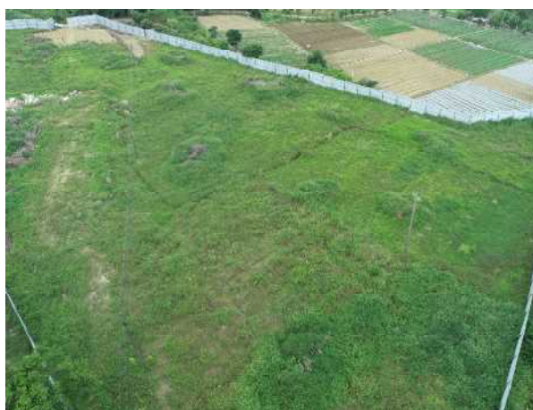
临时堆土区现状
